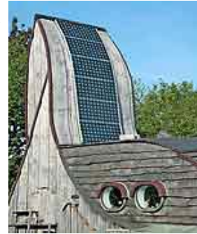
Nhà sinh thái lắp pin mặt trời sinh thái được xây
