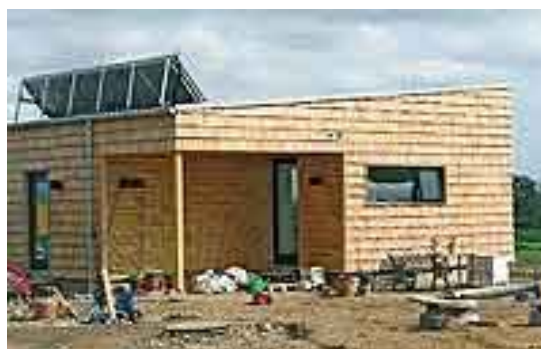
Nhà sinh thái xây từ gạch rơm, hoàn thiện bằng ván gỗ ở Làng sinh thái Friland
